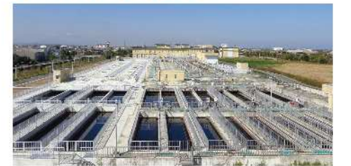
宮川浄化センター
